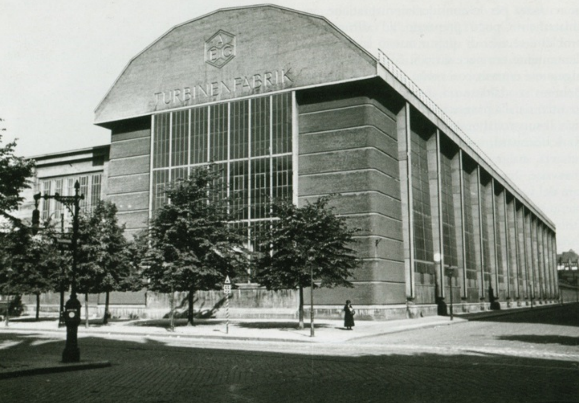
P. Behrens , Turbinenfabrik, Berlino, 1908
