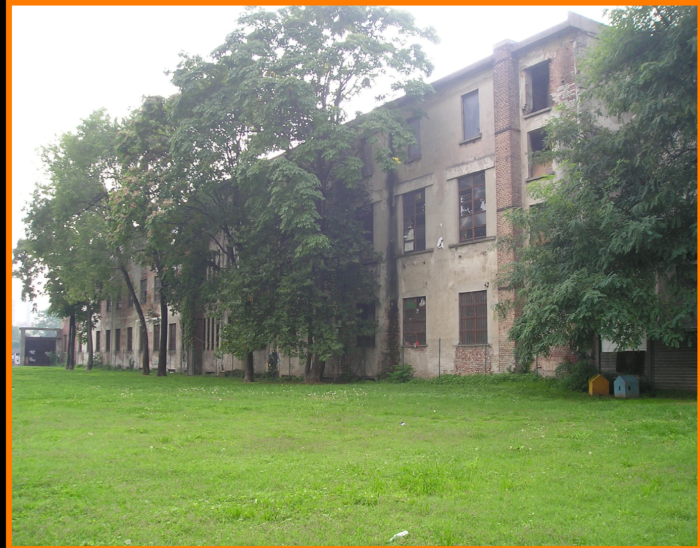
Immagine della Stecca degli Artigiani prima della demolizione
