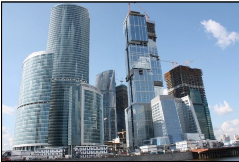
Moscow City, moderna città del lusso in costruzione nel centro di Mosca
